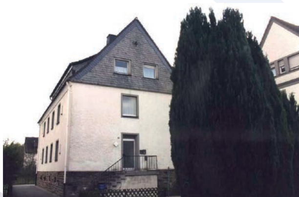
Eingang der Mittelstraße 7a um 2007
