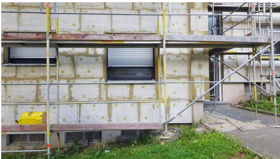
Erstellung einer Wärmedämmung an einem SBG-Gebäude
