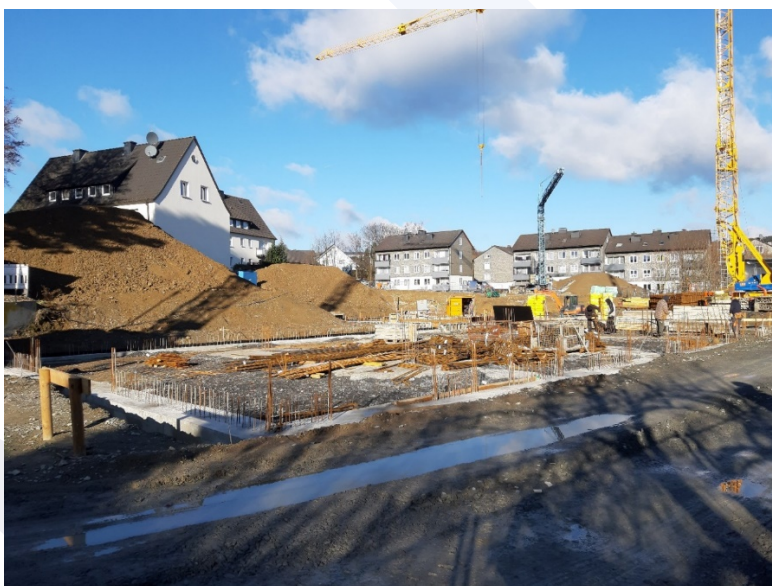
Fundamentierung Tiefgarage im Frühjahr 2022
