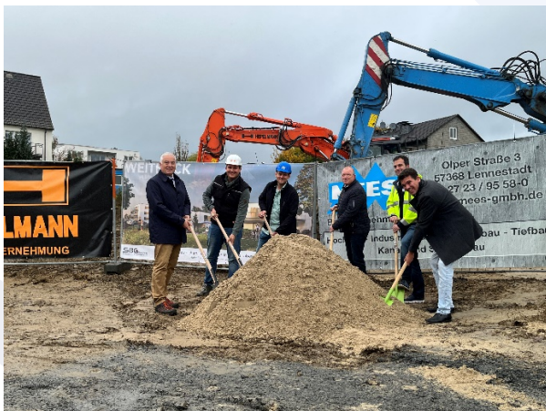
Spatenstich am 19. Oktober 2021
