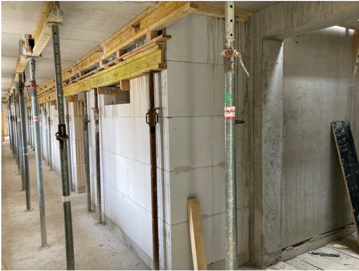
Aufgehendes Erdgeschoss, 3. Quartal 2022
