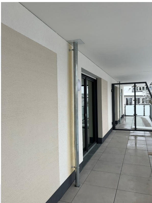
Balkone Haus 2, 1. Obergeschoss
