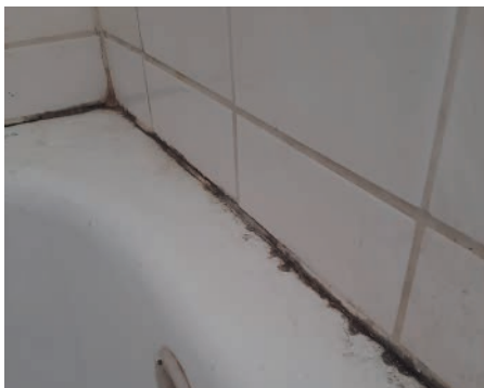
Beschädigte Wannenfugen
