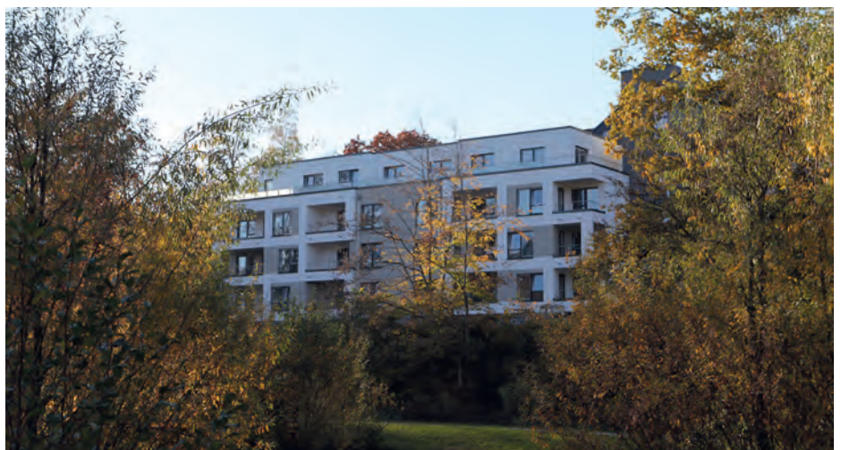
Blick aus dem Kurpark auf das Objekt „Wohnen im Park“, Eslohe
